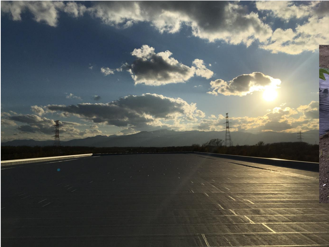
3階多目的室屋根よりサーバー室及び手稲山を望む
