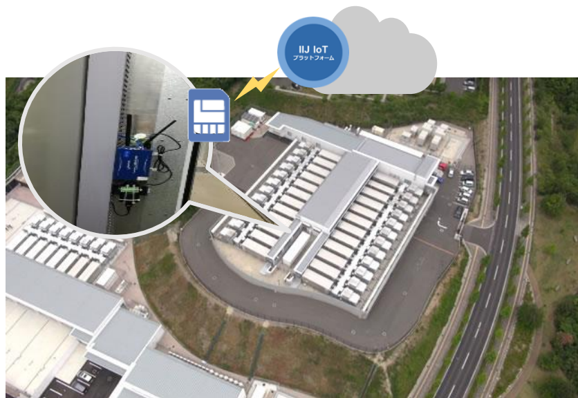
※IIJ 松江コンテナ型データセンターパーク
