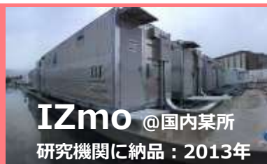
IZmo @島根県松江市 外気冷却コンテナ型DCの実現
